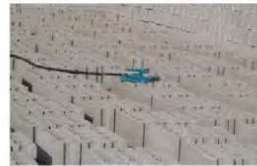
Fig. 13 Arrosage des blocs après 30 minutes
